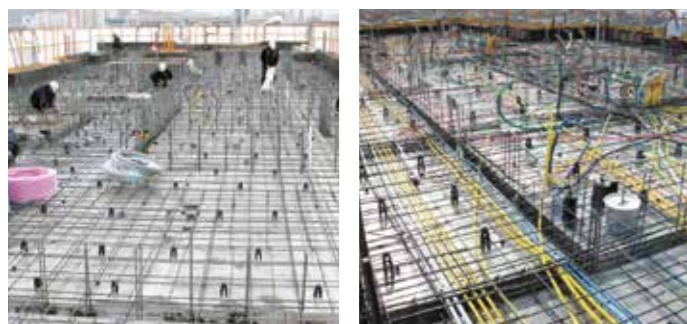
+7 전기 및 설비물 고정과 철근 배근
