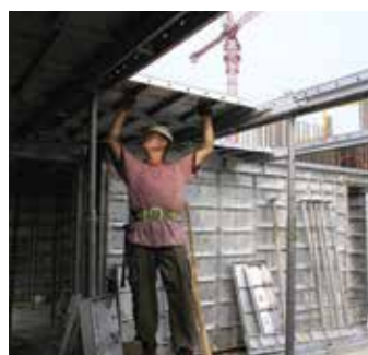
+5 Slab Form 설치
