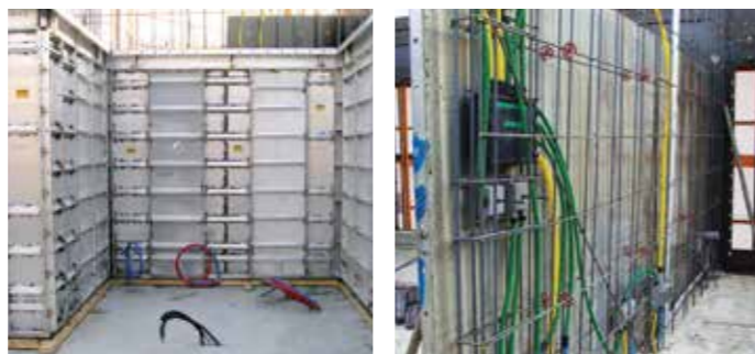
+2 Wall Form 설치
