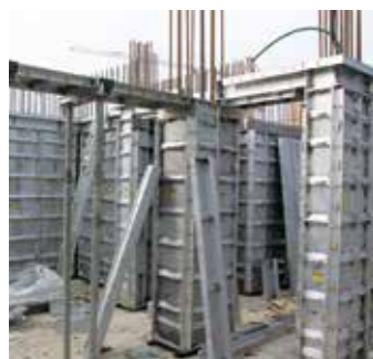
+3 Beam Panel 설치
