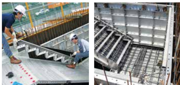
+4 계단 및 Elev-Pit 조립
