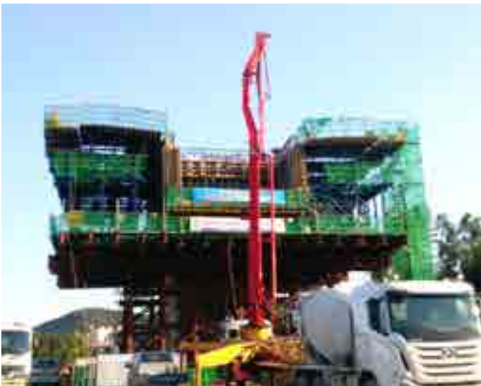
+ 옥동-농소간 1공구 오산대교
