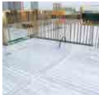
+6 Slab Form 완료 및 단열재 설치
