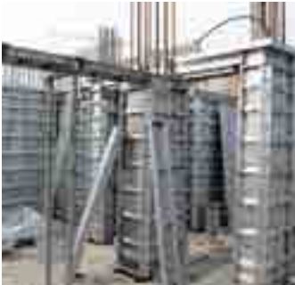
+3 Beam Panel 설치
