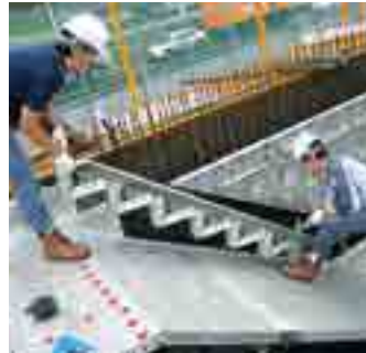
+4 계단 및 Elev-Pit 조립
