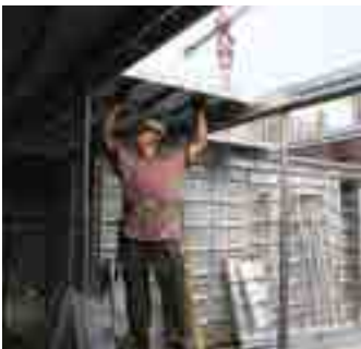
+5 Slab Form 설치
