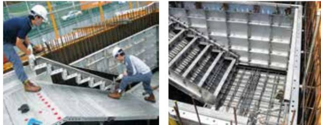
**+5** Instalación de paneles de losa.
