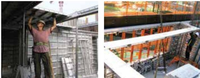
**+6** Instalación de paneles de losa.
