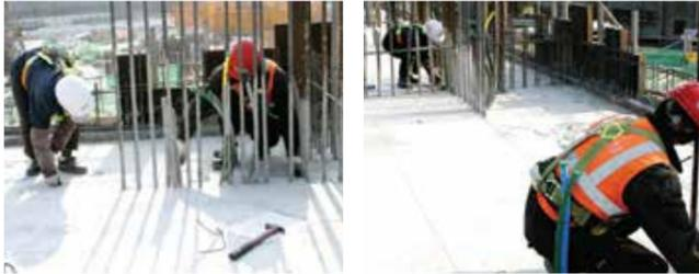
**+2** Instalación de componentes eléctricos, de fontanería y acero de refuerzo. Instalación de I / C y paneles de pared.
